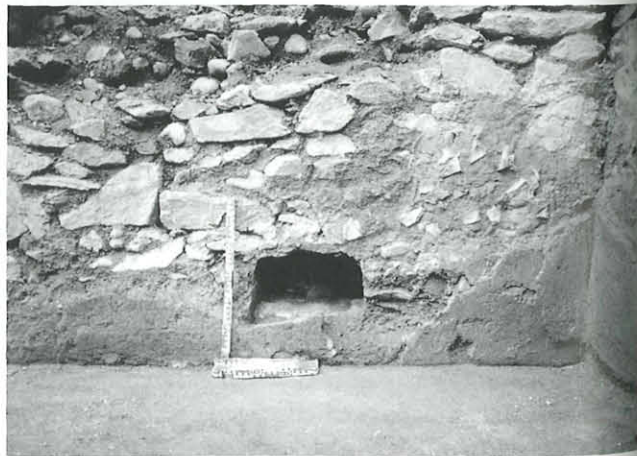
Abb. 5: Amphorenwandscherben zur Verbesserung der Trockenqualität von Wandverputz, Magdalensberg AA/46. Aufn. H. Dolenz
