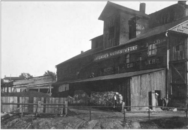
Abb. 70. Im Magnesitwerk Eichberg, Detailaufnahme, ca. 1930. Die Front des im oberen Bild großen unteren Gebäude mit den Sinteröfen. BBM Enzenreith.
