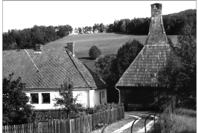
Abb. 50. Renovierter Flossöfen in Edlach (errichtet 1716) mit Bruderladenhaus. Foto N. VÖLKERER (1986; BBM Enzenreith).
