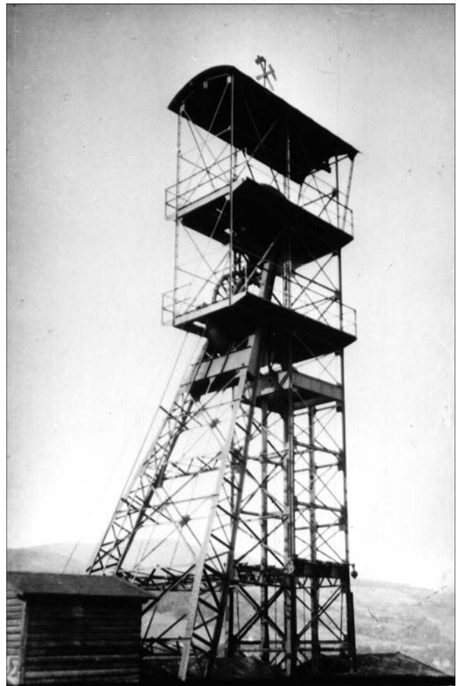
Abb. 17. Seilscheibengerüst des Braunkohlenbergbaues Hart bei Gloggnitz (Kap. 6, Nr. 139), ca. 1938. BBM Enzenreith.
