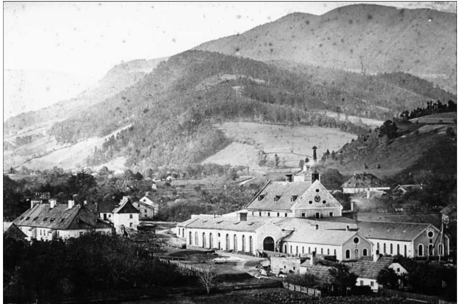
Abb. 52. Edlacher Stahlwerk um 1885. Rund um den Hochofen (das zentrale, höhere Gebäude) sind die Werkshallen und Gießereien gruppiert. BBM Reichenau.
