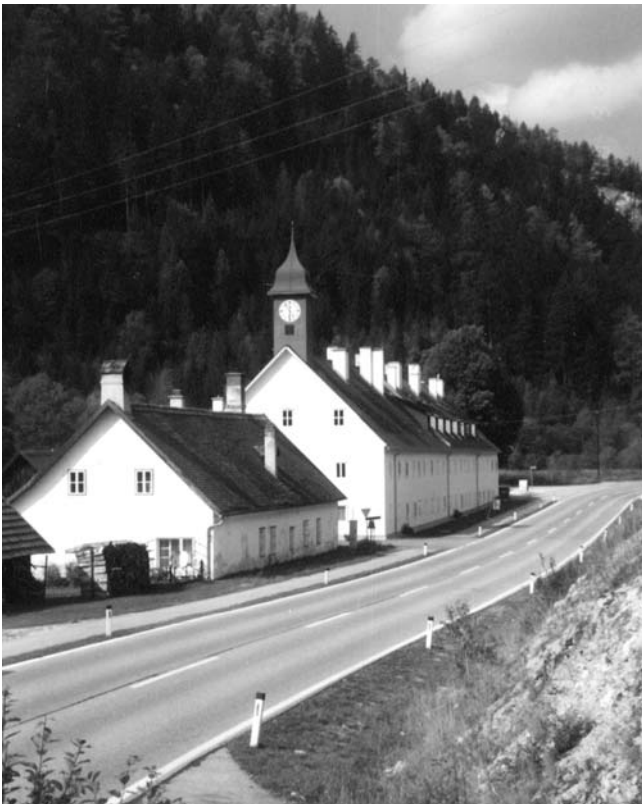
Abb. 63. Das Verwaltungsgebäude des Eisenwerkes Lanau, heute als Wohngebäude stark verändert und renoviert. Foto M. HACKENBERG (2000).
