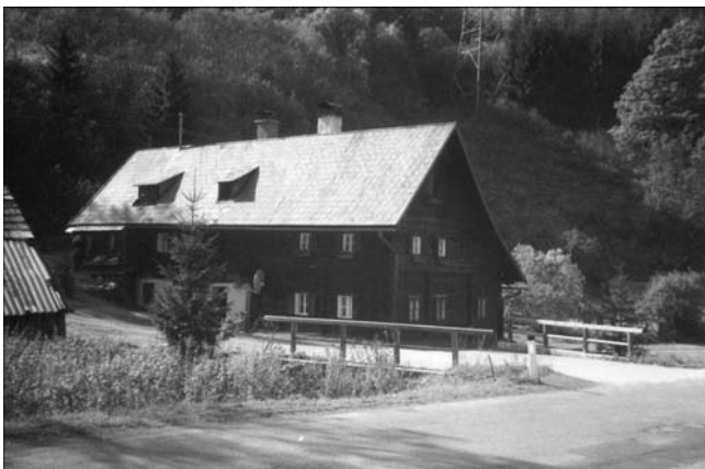
Abb. 85. Das ehemalige Knappenhaus des Revieres Frörschnitz, renoviert und stark verändert. Foto M. HACKENBERG (2000).
