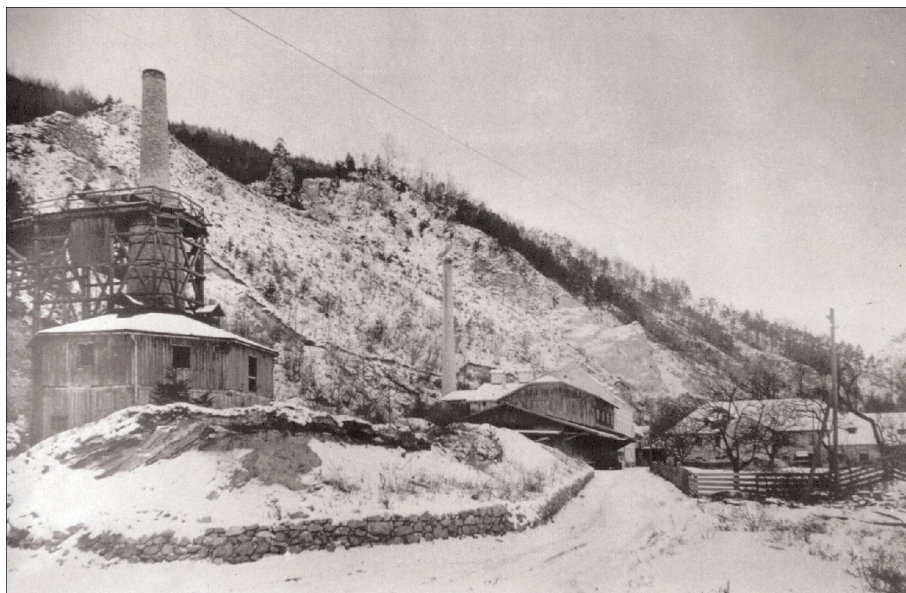
Abb. 93. Brennofen im Werk Schottwien (ca. 1935). Der Schornstein ist im oberen Bild ganz links unten erkennbar. BBM Enzenreith.
