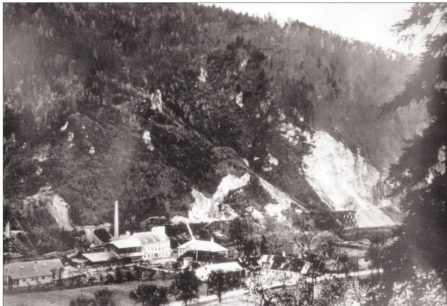
Abb. 92. Das Gelände des Gipswerkes Schottwien. Im Hintergrund ein Kalkbruch zur Gewinnung des Zuschlagstoffes mit der Fördertrasse. Die Abbaufelder lagen jenseits im S des Berges und waren mit dem Werk durch eine Förderstrecke verbunden. Dieser Stollen war bis vor kurzem im Eingangsbereich noch fahrbar. BBM Enzenreith.
