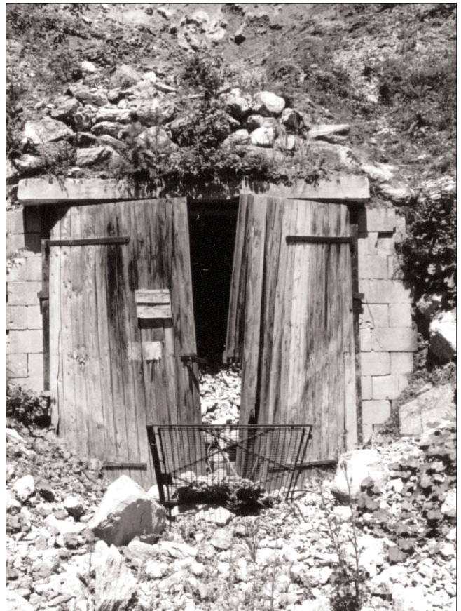
Abb. 83. Die Förderstrecke des Revieres Steinbach. In der mit den oberen Stollen gelöcherten Strecke haben die Betonüberlager dem Druck nachgegeben. Foto N. VÖLKERER.
