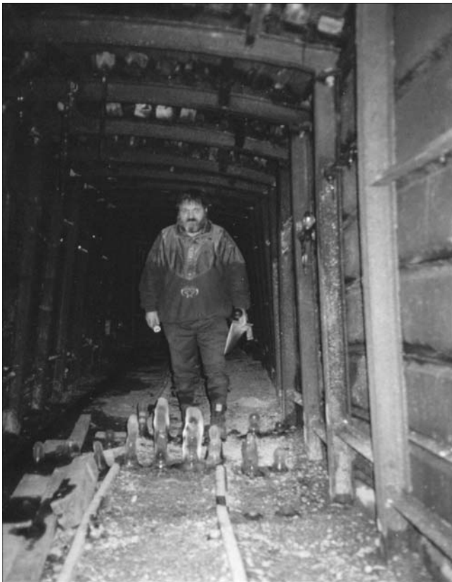
Abb. 37. Eismandeln im renovierten Förderstollen des Bergbaues Grillenberg. Das gebräuche Gebirge machte einen Vollausbau mit Ringausbau, Verzugsblechen und betonierter Sohle notwendig. Foto P. GOTTSCHLING (1995).
