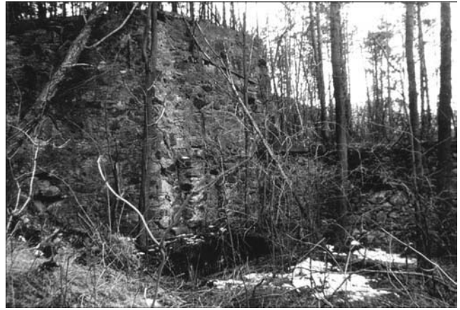
Abb. 35. Fundament der Bergstation der ehemaligen Materialseilbahn am Bergbau Grillenberg vor dem Mundloch des Herlinde-Stollens. Auf den hinteren Mauern ruhte das Plateau, auf dem die Röstöfen gestanden sind. Foto M. HACKENBERG (2000).
