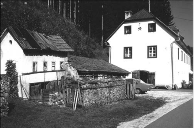
Abb. 58. Grubenhaus in Altenberg/Knappendorf (stark verändert; Wohnhaus). Im Gebäude war der Kaiser-Franz-Josef-Erbstollen angesetzt. Foto M. HACKENBERG (2000).
