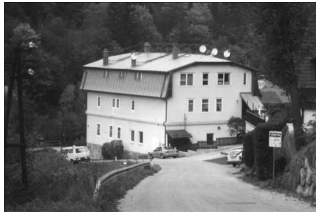
Abb. 98. Das ehem Gebäude der Betriebsleitung im Haidbachgraben (Katharinenfeld, Eugenefeld), heute zum Wohnhaus umgestaltet. Foto M. HACKENBERG (2000).
