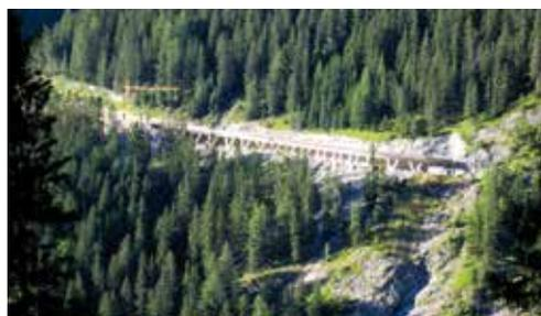
Neben dem Bau des Hauptbauwerkes, der 206 Meter langen Celleswaldgalerie im Anschluss an den Gstalda-Tunnel von km 6,9 bis km 7,2 der L 348 Spisser Straße, umfasste das Baulos die Errichtung einer Betriebsstation und von Stützmauern beim Portal Spiss zur Herstellung einer Auffahrt auf die Galerie sowie Straßenbau- und Entwässerungsarbeiten. Die Galerie kam als Gewölbequerschnitt mit talseitigen V-Stützen zur Ausführung.
