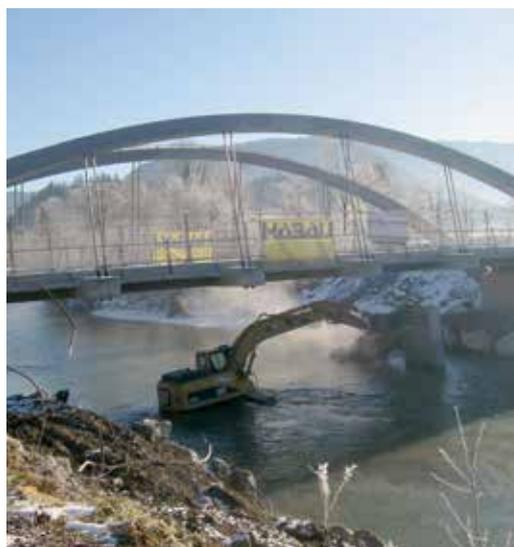
Bei der Umsetzung des Hochwasserschutzes Kössen, Gerinneausbau Landbrücke bis Hüttwirtsbrücke, war die bestehende 3-feldrige Hüttwirtsbrücke Kössen durch ein neues, Pfeilerfreies Brückentragwerk mit einem erforderlichen Freibord von 1,20 m über den neuen Bemessungswasserspiegel zu ersetzen.
