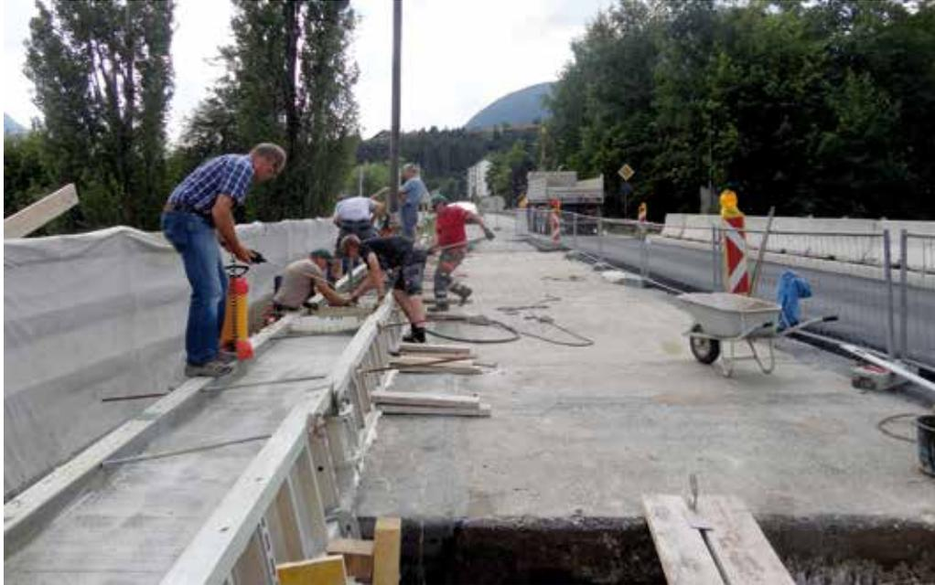
B 171, Unterführung Langgasse, Betonierarbeiten Randbalken-Rüstungsarbeiten
