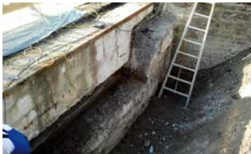
B 171, ZK1 Brücke über die B 171b, Erneuerung der Herdmauer
