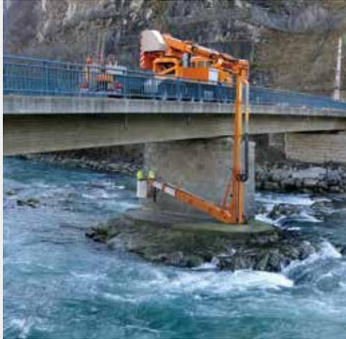
Pfeilersondierung mit Brückeninspektionsgerät
