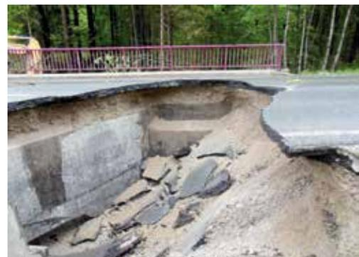
Die Wandmauer Kirchbichl stellte sich im Bestand als ein 8,00 m hohes, in Beton verlegtes Natursteinmauerwerk dar. Durch die massiven Hangwasserzutritte bedingt durch die Starkregenereignisse sackte die B 171 im Wandbereich deutlich ab. Ausbauchungen in der bestehenden Stützmauer waren erste Warnsignale hinsichtlich der Tragsicherheit der gesamten Stützkonstruktion.
