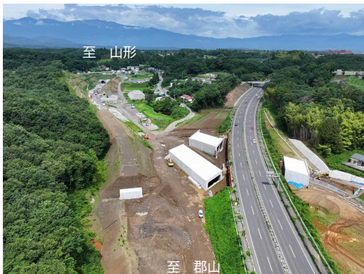
▲起点国道4号との接続部施工状況
