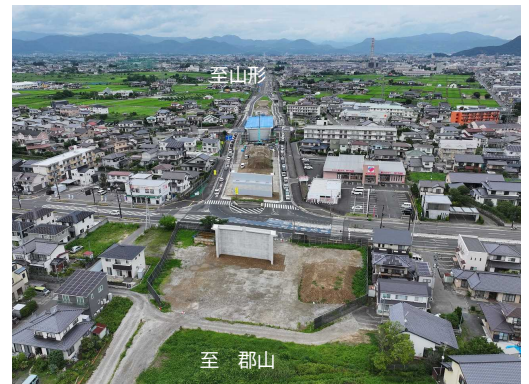
▲(仮)西ノ内こ道橋施工状況
