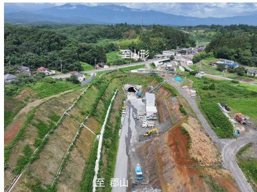
▲(仮)浅川トンネル起点側坑口施工状況
