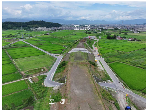
▲盛土区間施工状況
