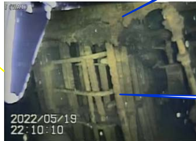
写真3.ペDESTAL開口部(右側基礎部)の堆積物より下部の状況
