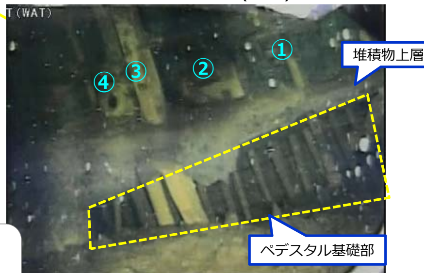
写真2.ペDESTAL基礎部(下部)の状況
