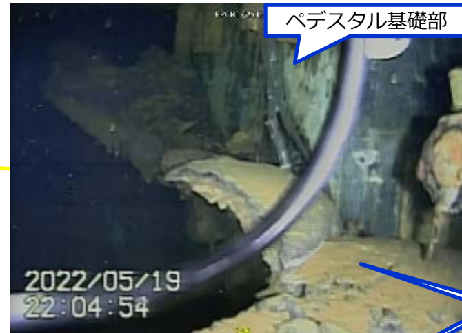
写真1.ペDESTAL開口部(右側基礎部)の堆積物より上部の状況
