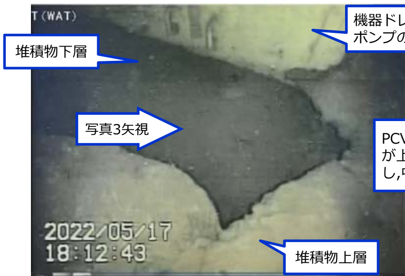
写真2.PCV底部の堆積物の状況
