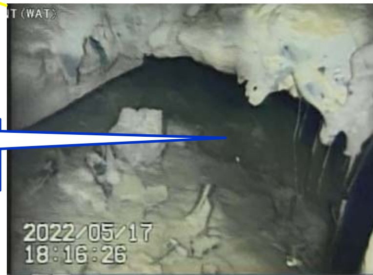
写真3.PCV底部の堆積物の状況(空洞内部)
