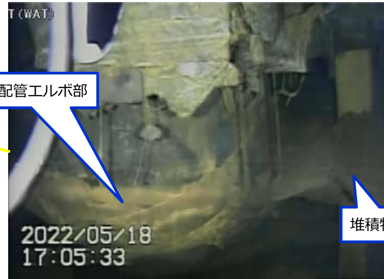
写真1.PLR(A)配管の状況
