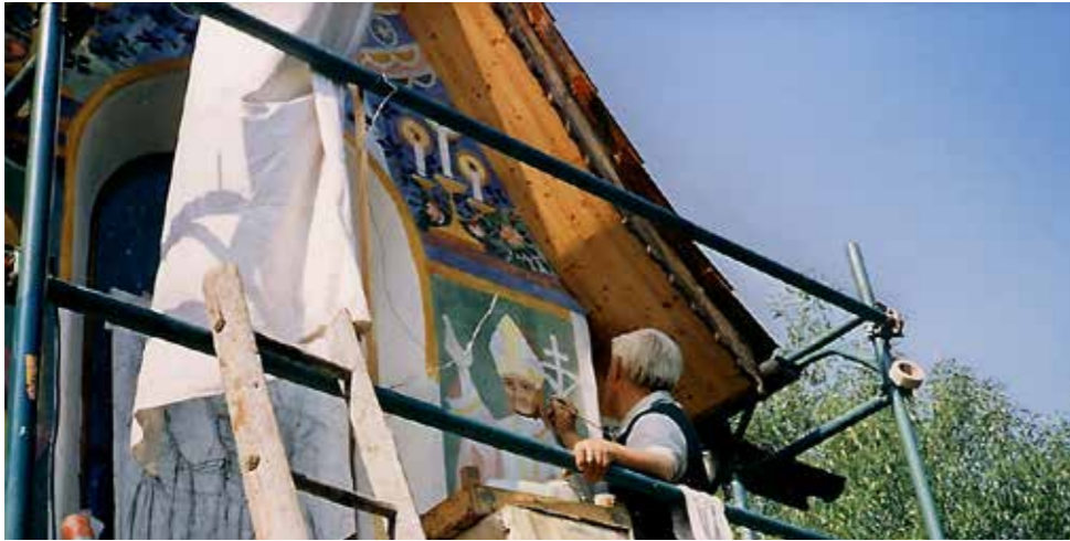
Arbeiten an der Tregister Dorfkapelle, 1986–1992
