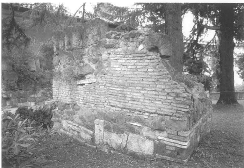
Fig. 12. Giardini Vaticani: tratto B delle mura leonine (lato interno). Fig. 13. Giardini Vaticani: tratto C delle mura leonine (lato esterno).
