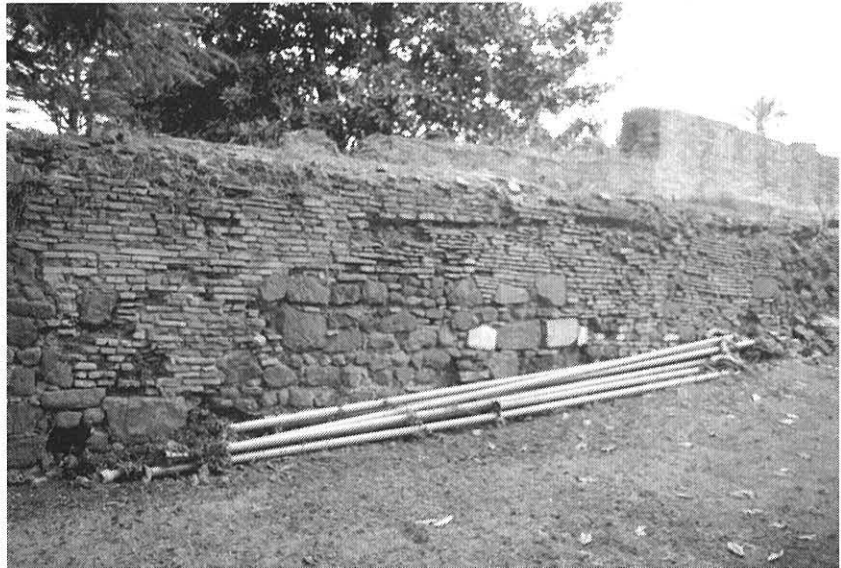
Fig. 10. Giardini Vaticani: particolare della zona di scaglie di marmo sul lato interno del tratto A delle mura leonine.
