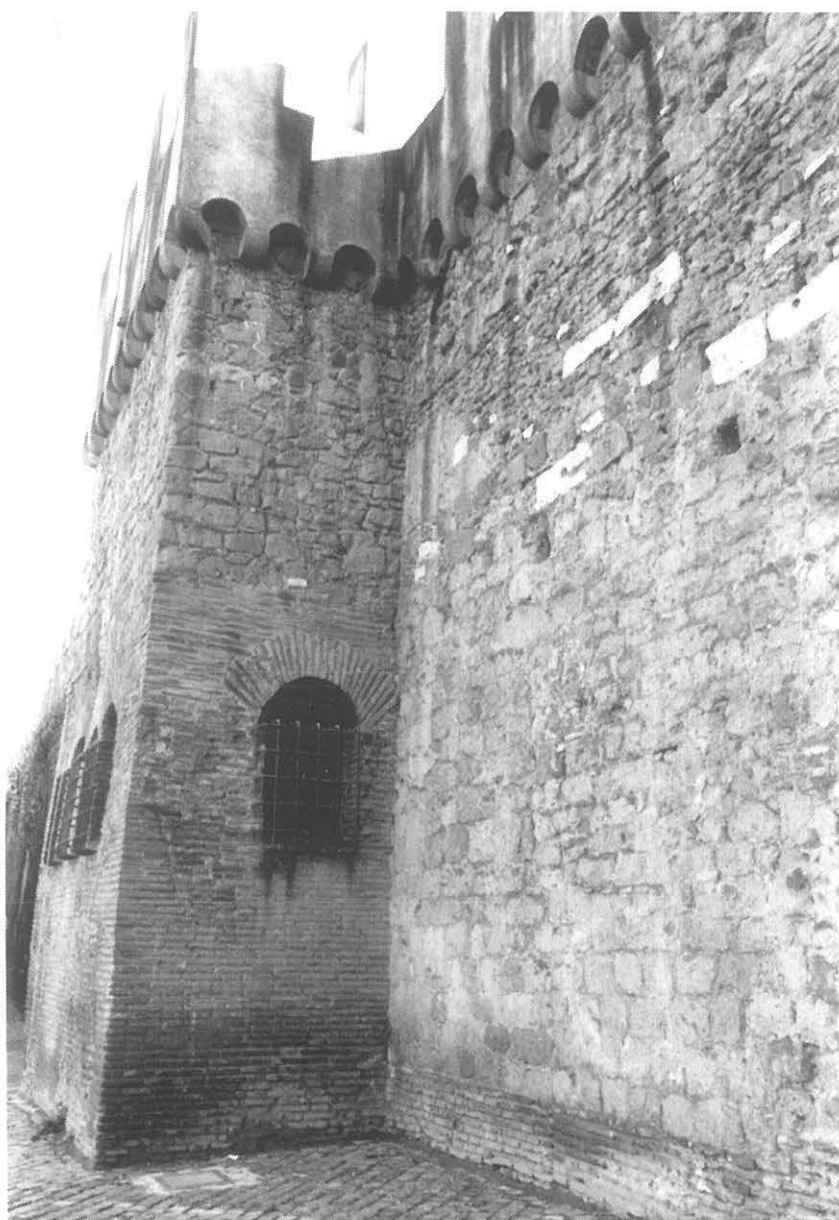
Fig. 26. Passetto: torre in piazza della Città Leonina con alla base resti della cortina di IX secolo (lato esterno).
