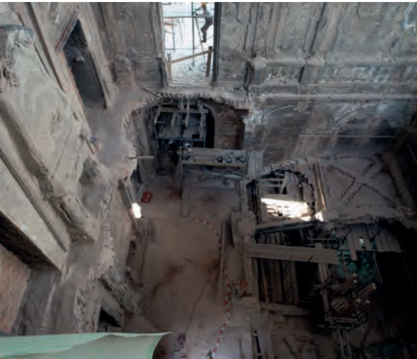
21 Das Treppenhaus nach dem Rückbau der einsturzgefährdeten Gewölbekappen der Treppenkonstruktion
