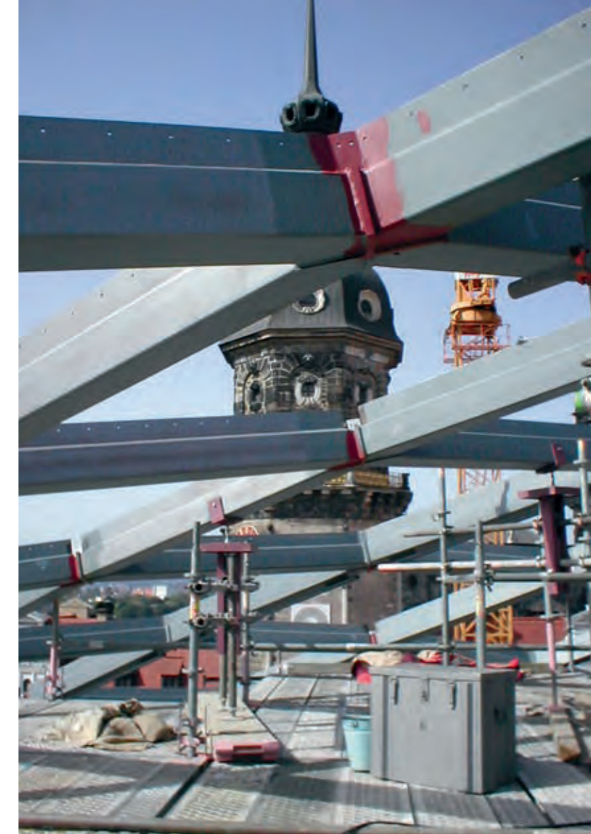
13 Baustellensituation beim Aufbau der Vierkanttragprofile
