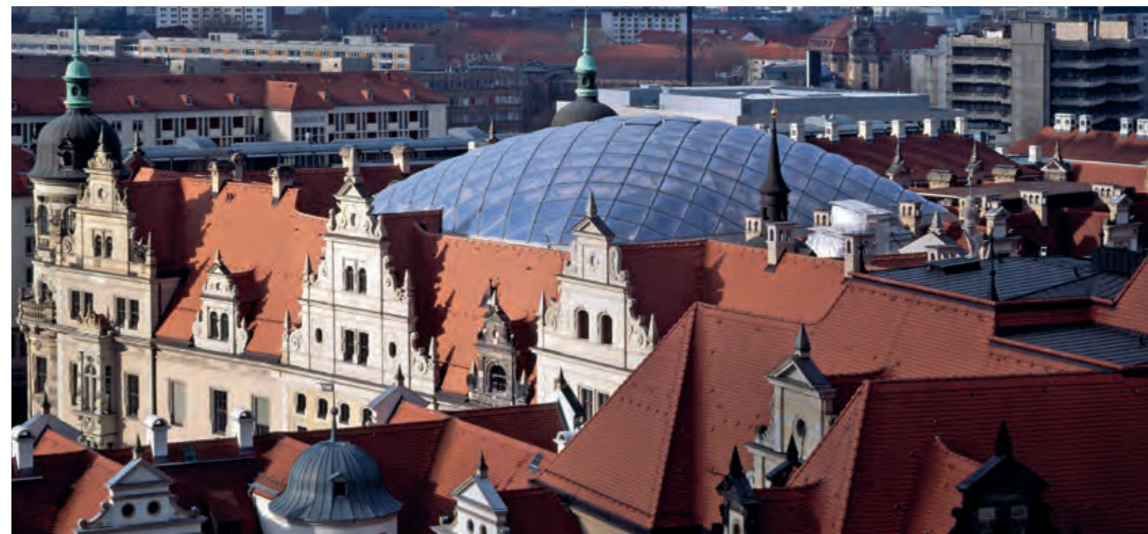
11 Um eine Kuppel reicher: Die Form passt sich gut in die Dächerlandschaft des Schlosses ein. Gleichzeitig wird von außen sichtbar, dass hier der zentrale Verteiler für die Besucher entstanden ist. Im Schloss tauchen die Rauten auch an vielen anderen Stellen auf, beispielsweise am Gewölbe des Riesensaals.
