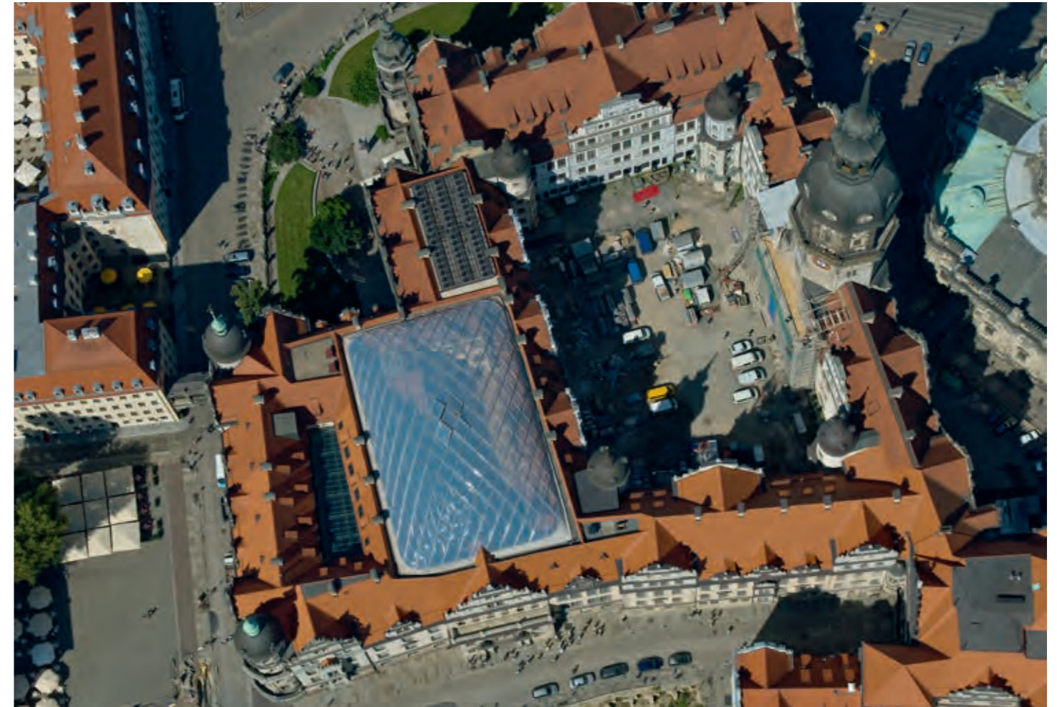
05 Luftbildaufnahme von 2009: Während zahlreiche Gebäudeteile seit Jahren öffentlich genutzt werden, wurde der Große Schlosshof als Baustelleneinrichtung benötigt
