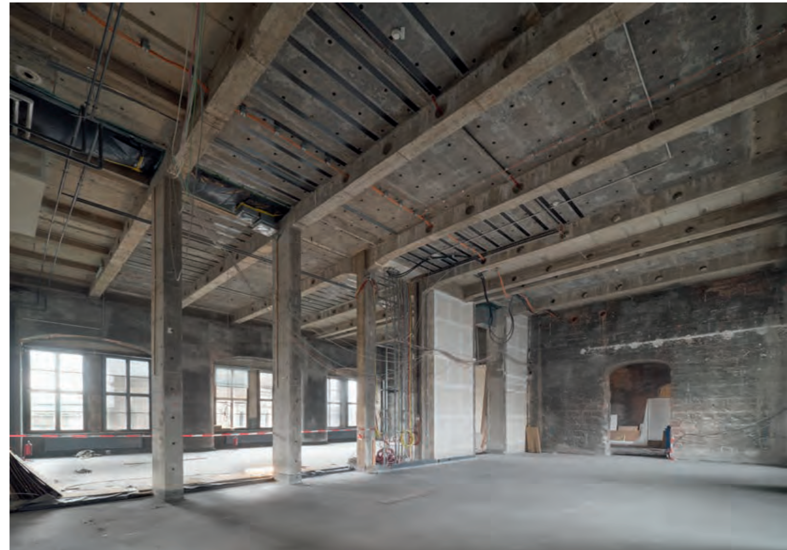
54 Der Zustand vor der Rekonstruktion war durch die Ende der 1980er-Jahre realisierten Sicherheits- und Rohbaumaßnahmen geprägt
