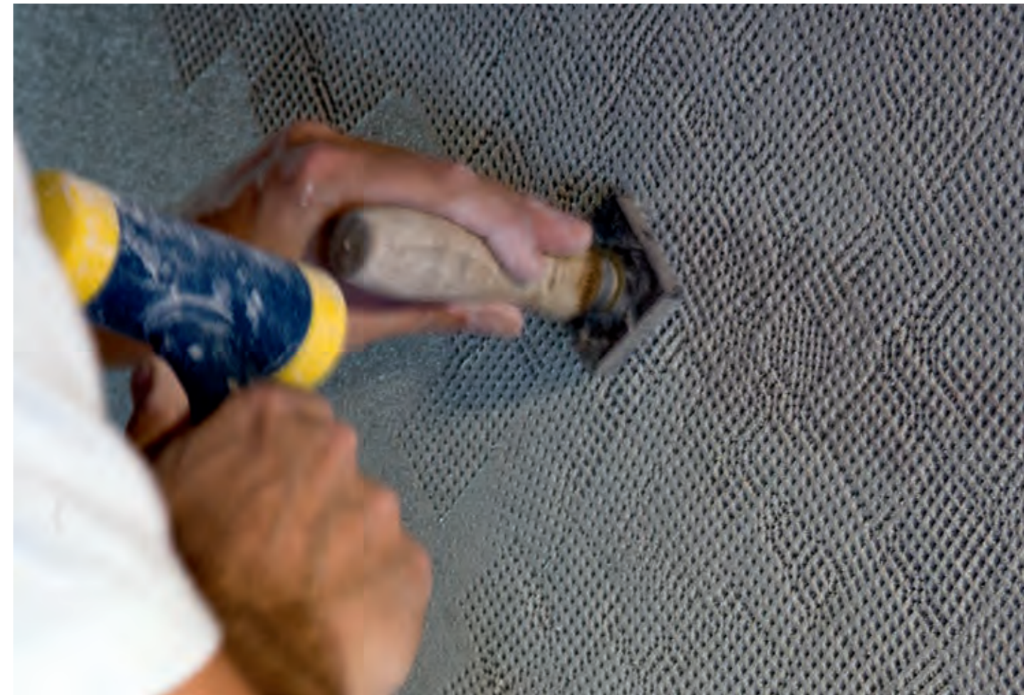
23 Zur Rekonstruktion der typischen Putzoberfläche wurden besondere Prägwerkzeuge eingesetzt
