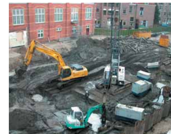
Na de verhuizing van medewerkers en collectie werd begonnen met de sloop van het Veiligheidsinstituut. Op deze plaats zal in de komende jaren het Ateliergebouw verrijzen.
