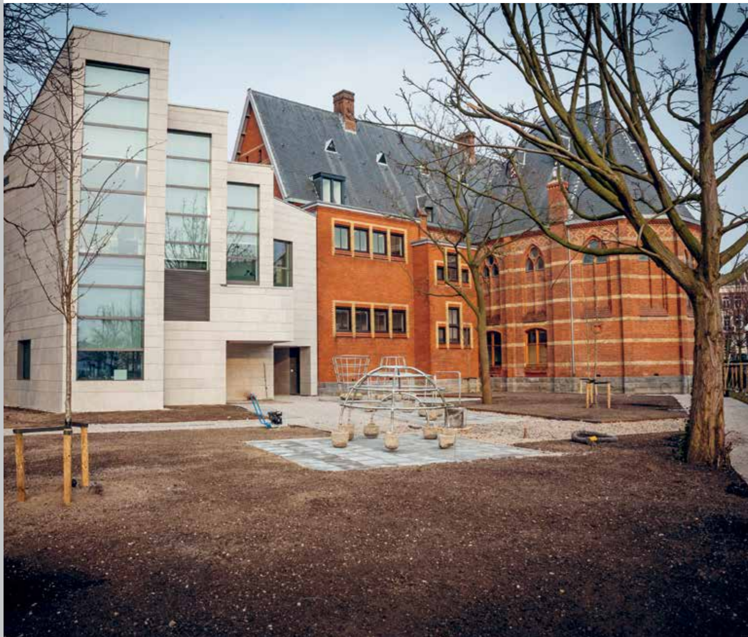
Het nieuwe Entreegebouw (ingang voor medewerkers en leveranciers) naast de Teekenschool
