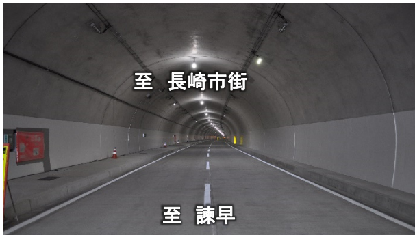
写真④トンネル坑内
