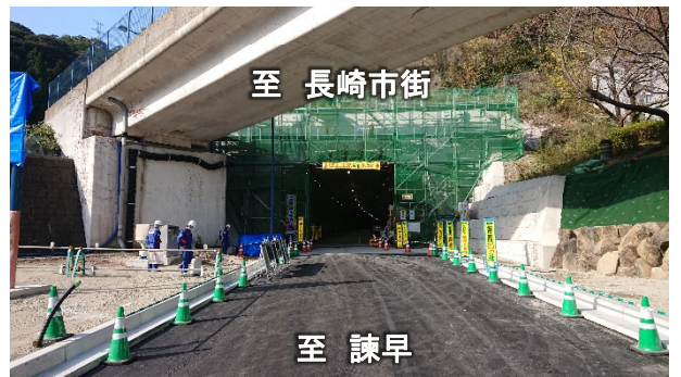
写真③トンネル坑口(芒塚側)
