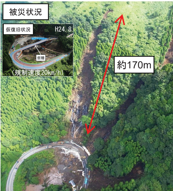
▲ 被災状況 (H24. 7) と仮復旧状況 (H24. 8)
