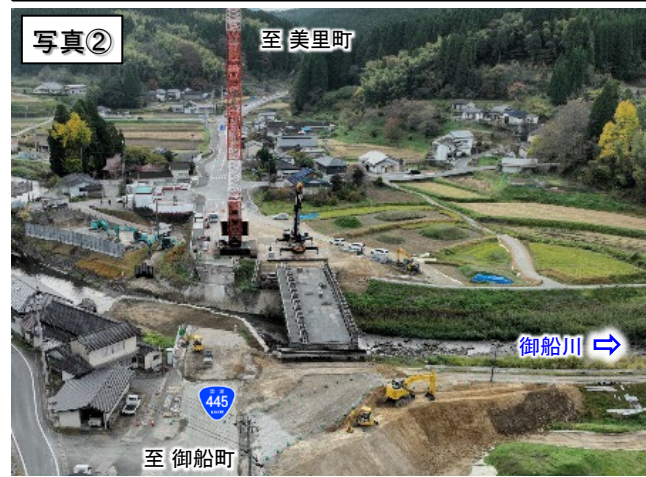
▲ 仮橋上部工を施工中
