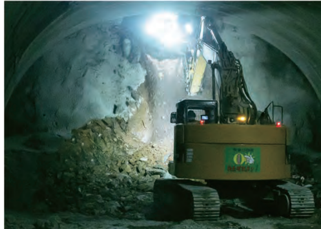
岡垣トンネルの堀削 (R3.2完成)
