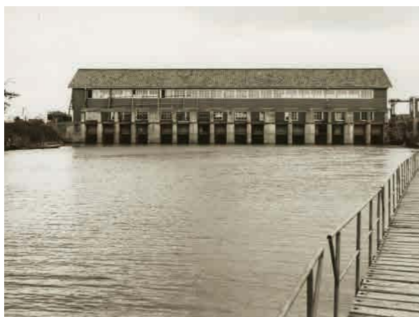
栗ノ木排水機場 (所蔵：亀田郷土地改良区)
