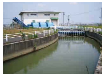
環境用水を導入する舞潟揚水機場
