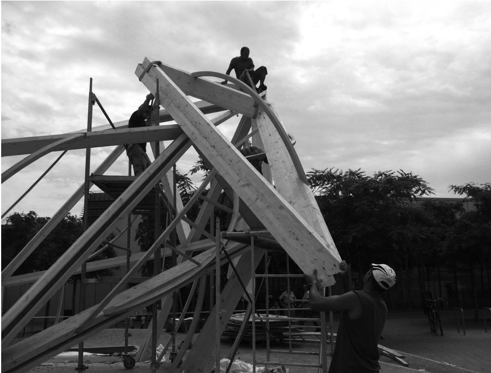
Endesa Pavilion. Instalación de los módulos de fachada. Barcelona 2011.
