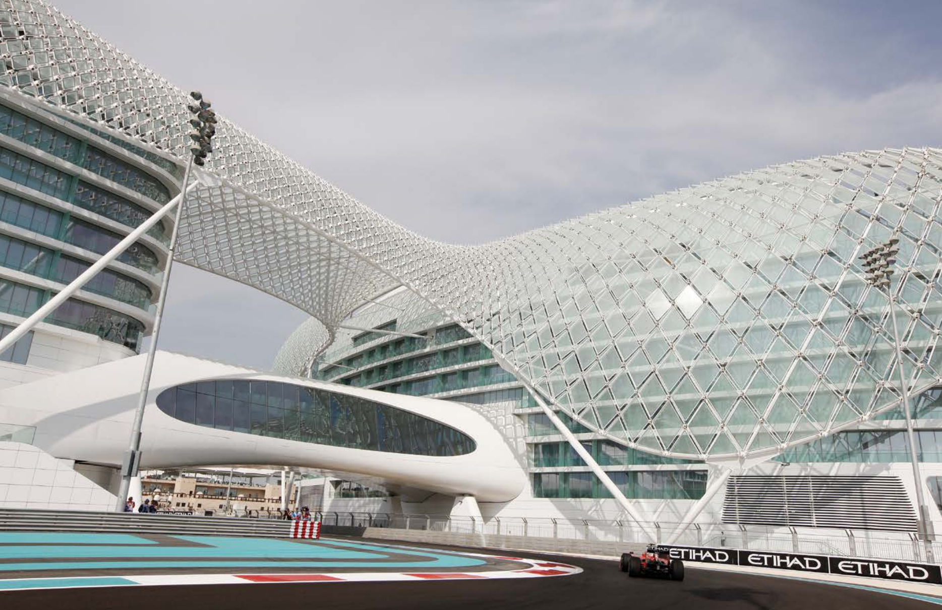
Un gran puente sin apoyos tipo fuselaje de acero cruza sobre la pista de F1 y conecta ambas torres del hotel.
