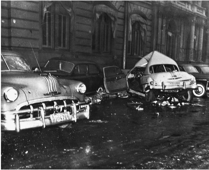
Frente de Casa de Gobierno (automóviles deteriorados por bombas explotadas)
