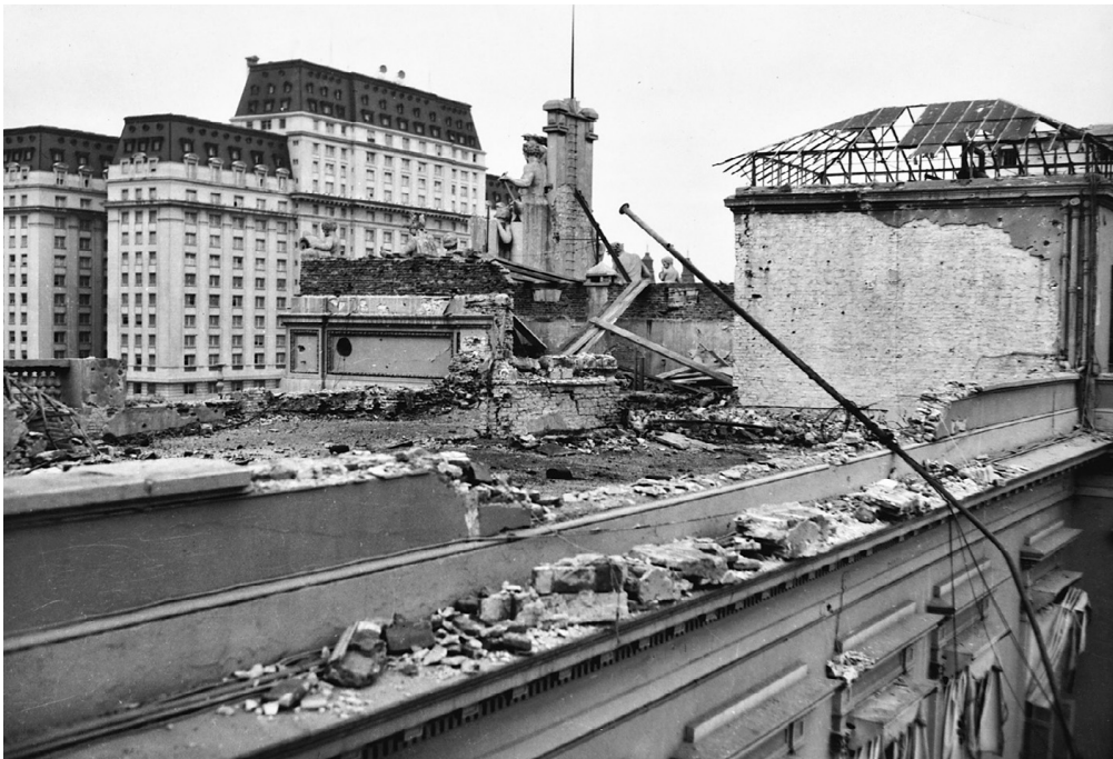
Azotea sobre Paseo Colón (destrozos causados por bombas explotadas)
