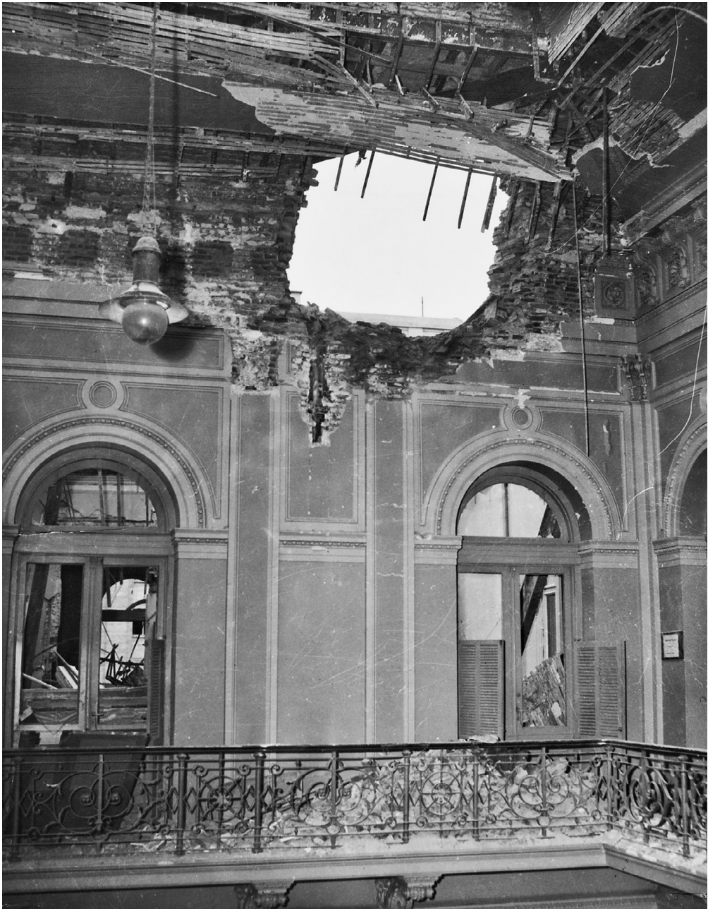
Techo del 2º patio y dependencias de la Secretaría de Informaciones de Estado (destrozos causados por bombas explotadas)
