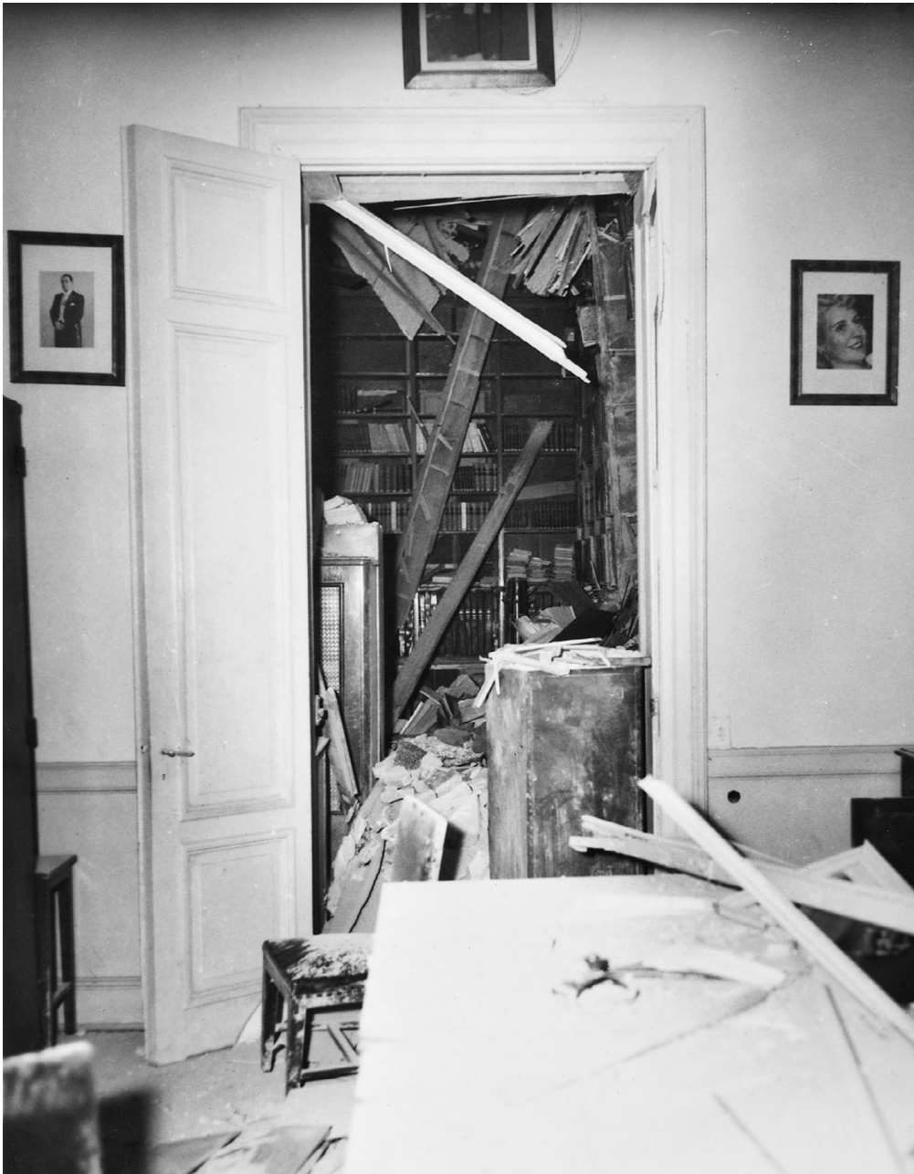
Biblioteca del Ministerio del Interior (destrozos causados por bombas explotadas)
