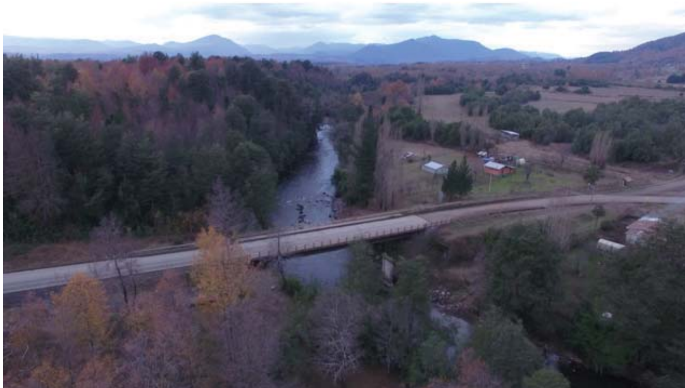
Fotografía nº1: Imagen Aérea Río Cautín, Volcá
