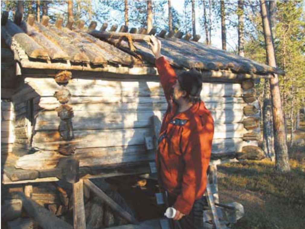
Arto Enojärvi tutkiskelee tuohikaton rakennetta Arvidsjaurissa
