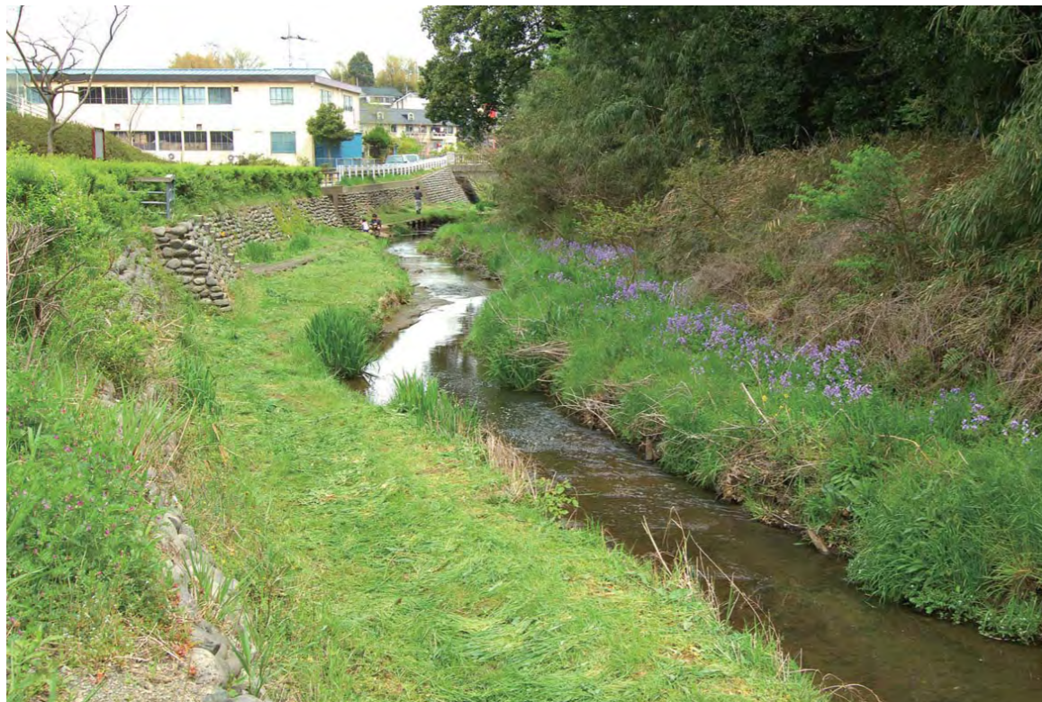
2007年（施行後約14年経過した状況） Umeda River after repairs (2007)
