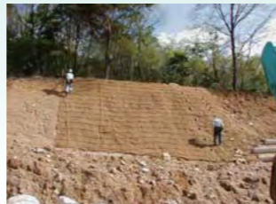
施工中の状況 (2002年5月) Slope in May 2002
