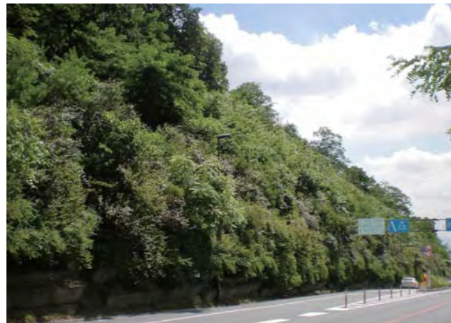
施工後8年 (2010年8月) Slope in AUG 2010
