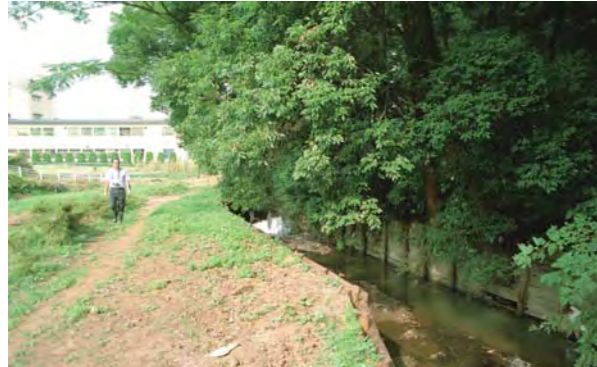
1992年（改修前の状況） Umeda River before repairs (1992)
