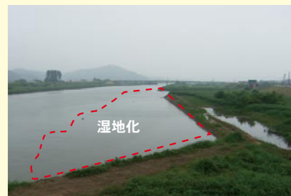
改修後(2007年6月) After reconstruction in June 2007
