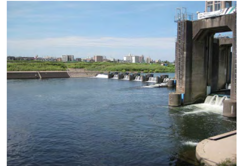
現在の多摩川の様子（田園調布取水堰付近） A scene of Tama River today
