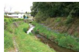
■多自然川づくり (1990)
