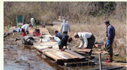
主力の市民ボランティアが、自分たちで運んだヒノキ原木を厚板に 削り出し、泥にまみれて敷設した本格的な手づくり木道
