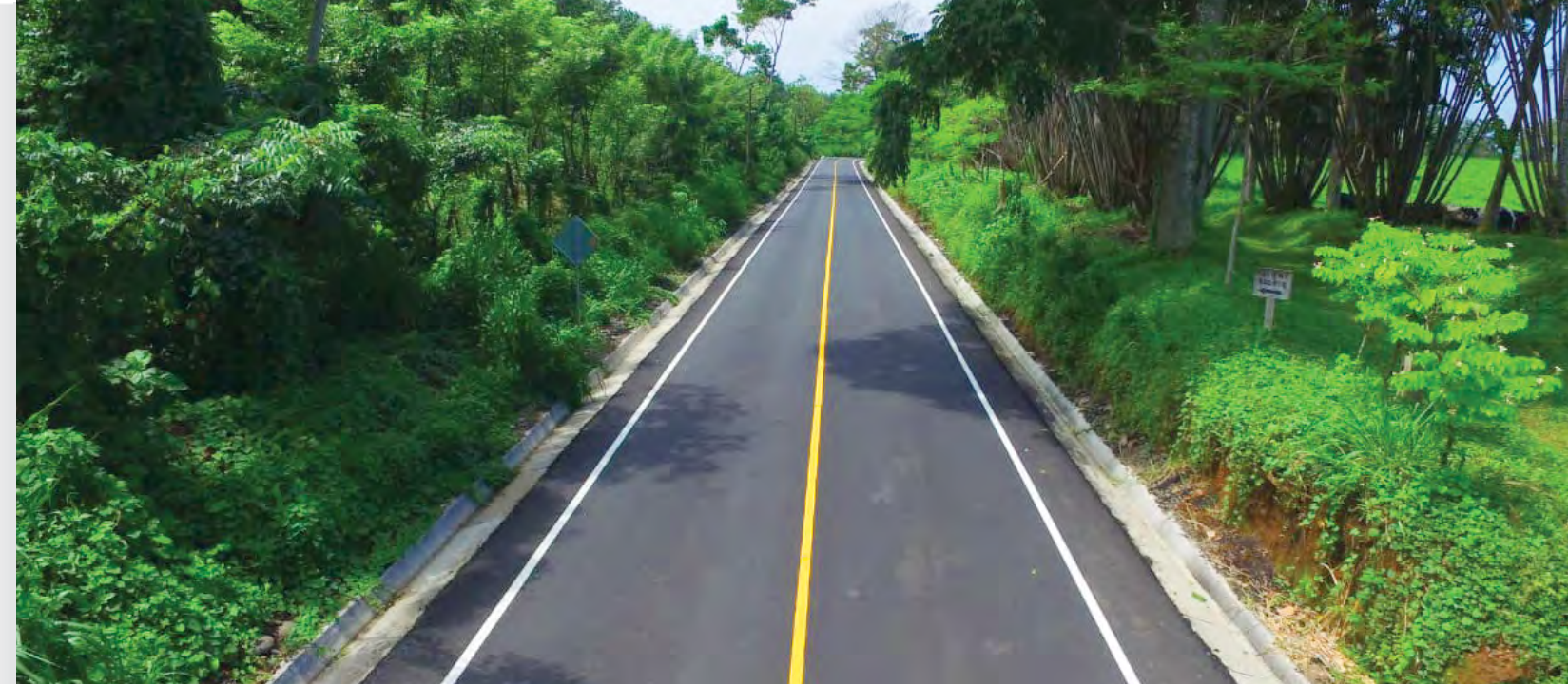
Reposición de la carretera CA-2 Occidente, aldea San Miguelito, Génova, Quetzaltenango. Foto: SCSPR.
