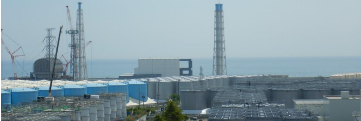
処理水を貯蔵しているタンク群
