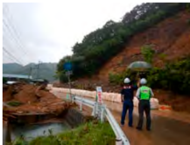
山地の被災状況調査(令和2年7月豪雨)
