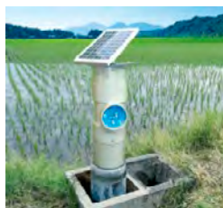
水田の水管理を遠隔・自動制御 できる水管理システム
