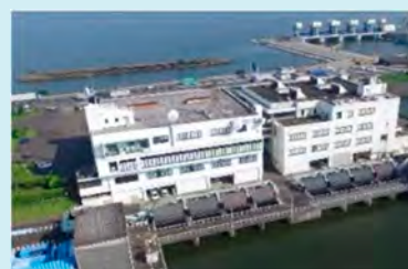
対策後の排水機場全景
