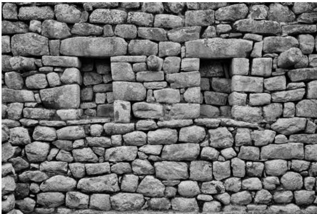
Figura 42. El muro de la figura 48 en la actualidad (fotografía: José M. Bastante).
