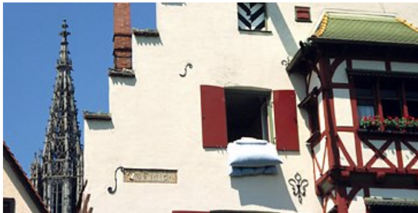
Sanierte Häuser aus dem Mittelalter am Münsterplatz
