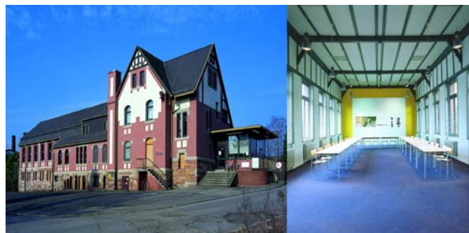
Saniertes Kantinegebäude und Pförtnerhaus
