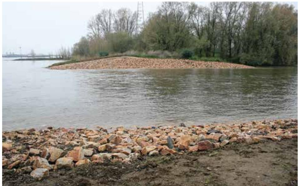
Abb. 6: Mit Wasserbausteinen gesicherter Einlaufbereich der Nebenrinne Emmericher Ward; Sohlbreite 30 Meter. Foto: K. Markgraf-Maué
