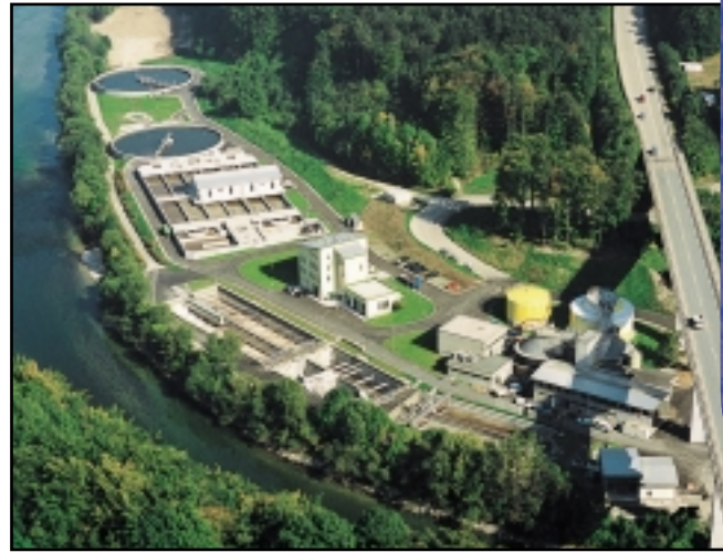
Kläranlage RHV Traunsee-Nord
