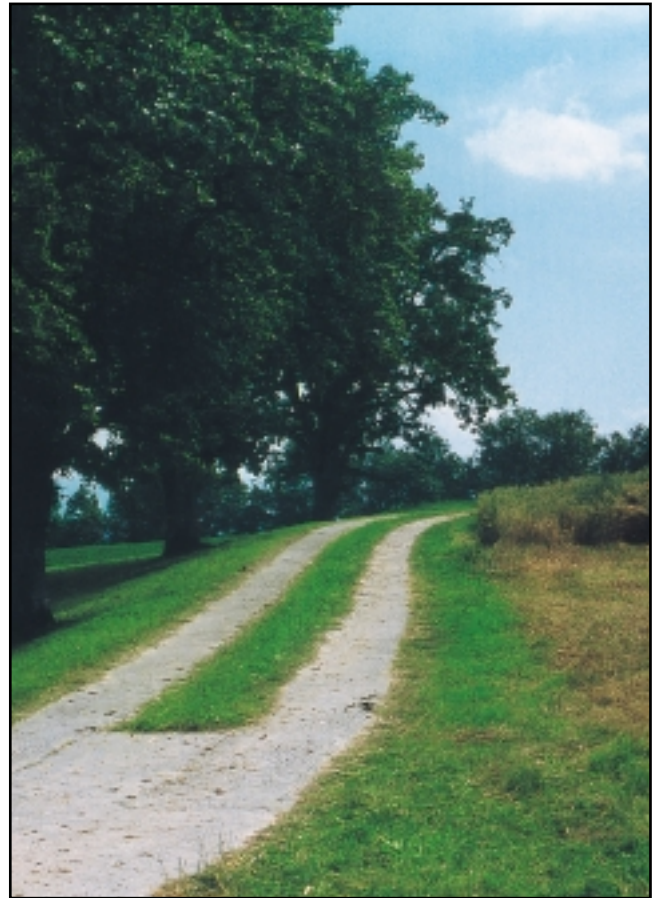
Betonspurwege erfüllen die Anforderungen an einen zeitgemäßen Weg
