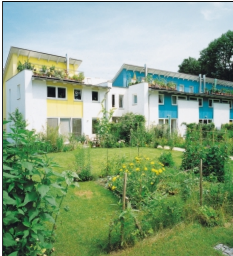
Verdichteter Wohnbau spart wertvolles Bauland
