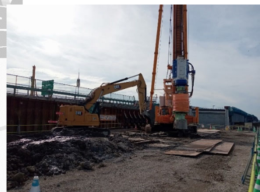
地盤改良工事施工状況
