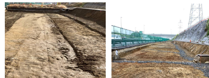
路床面の状況
