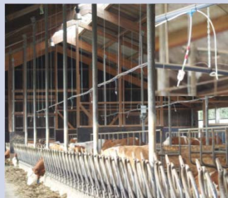
Messleitung mit Entnahmepunkten über kritische Kapillare im Milchviehstall (© B. Eurich-Menden)
