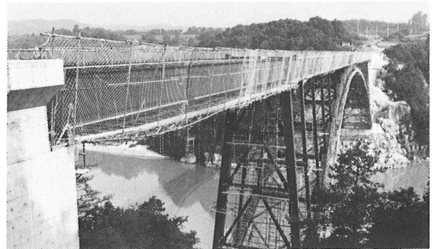
写真-2 架設完了
