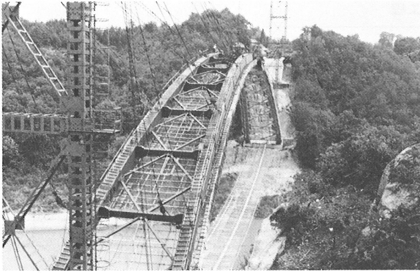
写真-6 アーチリブ架設状況
