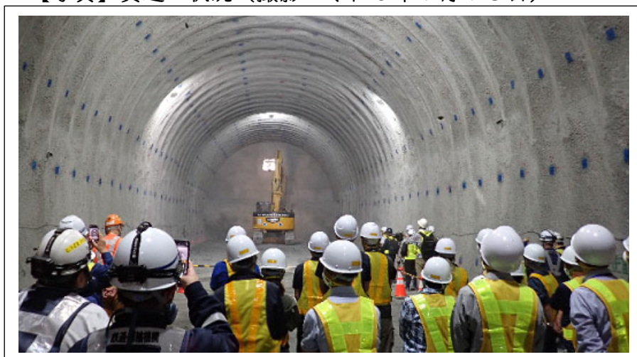
【写真】貫通の状況（撮影：令和6年7月18日）
