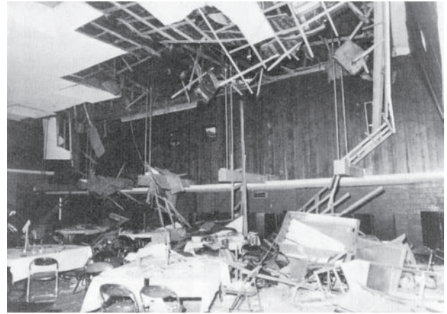
図3-11 「昭和57年(1982年)浦河沖地震」による浦河町福祉センターの天井の落下 [浦河町提供]
