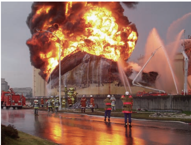
図3-23 「平成15年(2003年)十勝沖地震」の影響で火災が発生した苫小牧の石油タンク [総務省消防庁提供]
