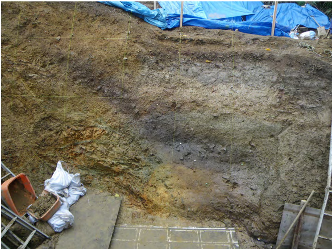
図19 秋葉トレンチ壁面の写真 上：東壁面，下：西壁面
