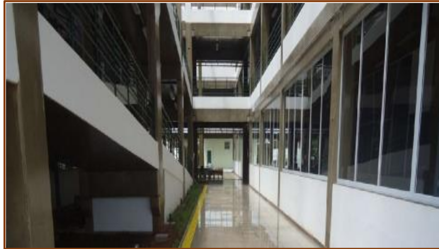
Câmpus Sertãozinho – Ampliação
