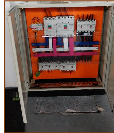
Câmpus São Roque – Ampliação da Potência (Troca do transformador)
