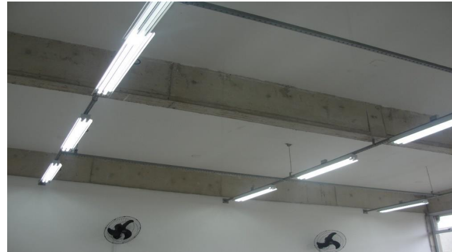
Câmpus Suzano – Instalação de Lâmpadas a LED
