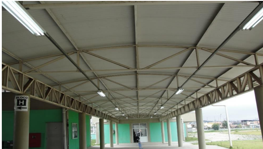
Câmpus Suzano – Instalação de Lâmpadas a LED
