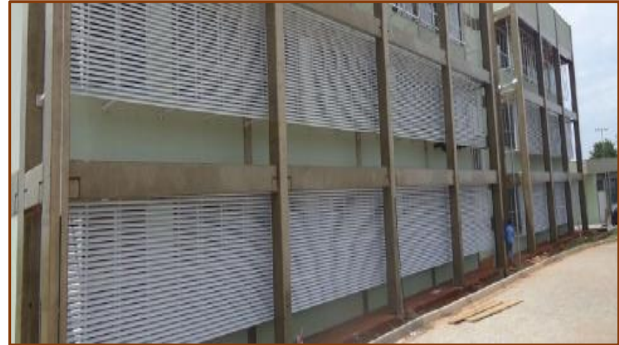
Câmpus Sertãozinho – Ampliação
