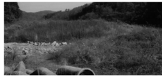
写真② 造成中の状況
