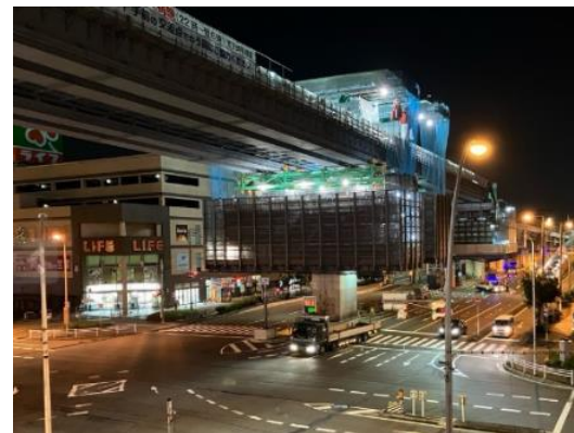
【工程短縮例：防音対策により昼夜間連続作業を実施】
