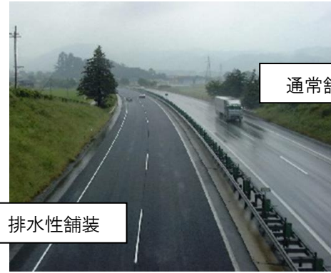
排水性舗装の施工例
