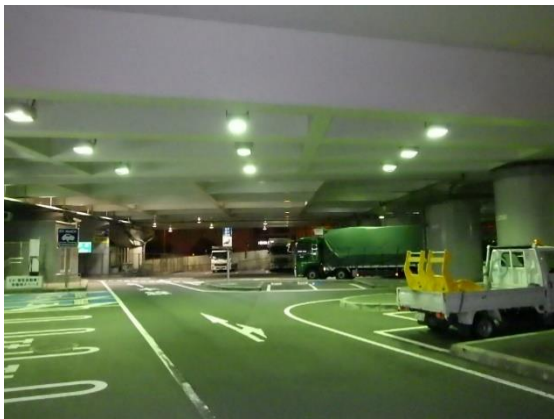
道路照明の LED 化の事例(京橋 PA)
