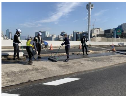
高性能床版防水の施工状況
