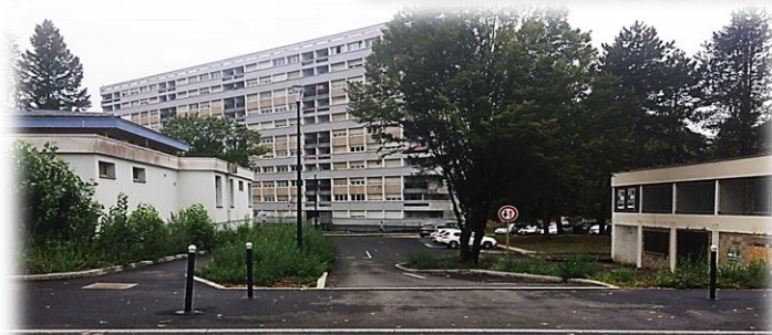
Maillage Dijon Picardie (travaux terminés)
