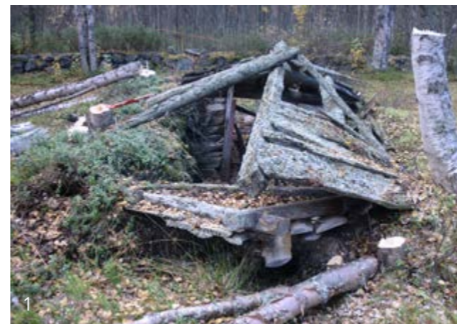
1. En «masstuggu» (lagerhus for mat) som delvis var rast sammen. 3/4. Ved å undersøke restene av huset, kan man gjenskape det slik det var, med materialer og håndverksteknikker som tidligere brukt.
