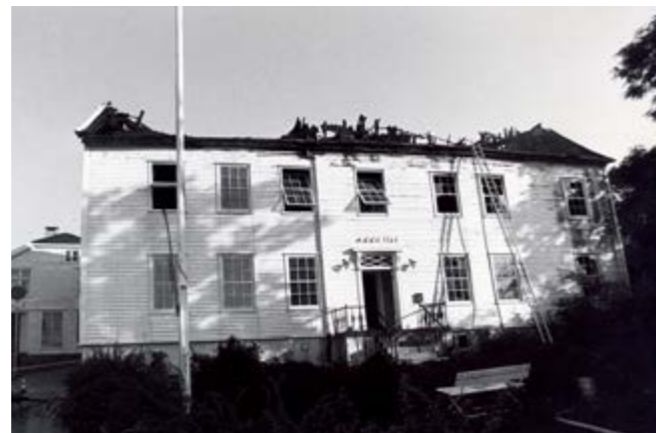
I 1976 ble huset sterkt skadet av en brann.
