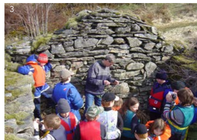
3. Skodvin skole restaurerer et gammelt hus.
