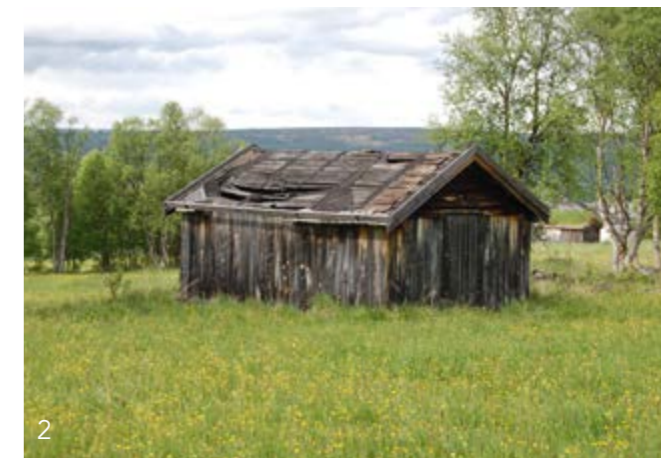
1. En «masstuggu» (lagerhus for mat) som delvis var rast sammen. 3/4. Ved å undersøke restene av huset, kan man gjenskape det slik det var, med materialer og håndverksteknikker som tidligere brukt.
