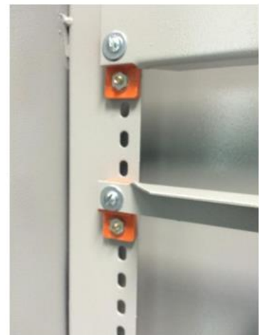
Figura 2: Detalhe da longarina e aplicação dos isoladores
