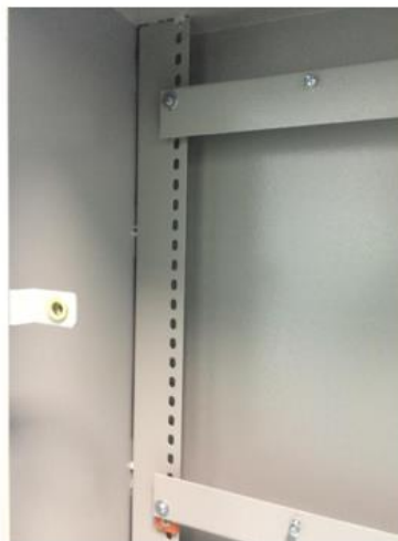
Figura 2: Detalhe da longarina e aplicação dos isoladores
