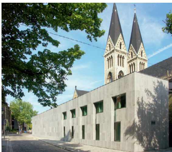
Abb. 6: Funktionsgebäude (Foto Kalisch)
