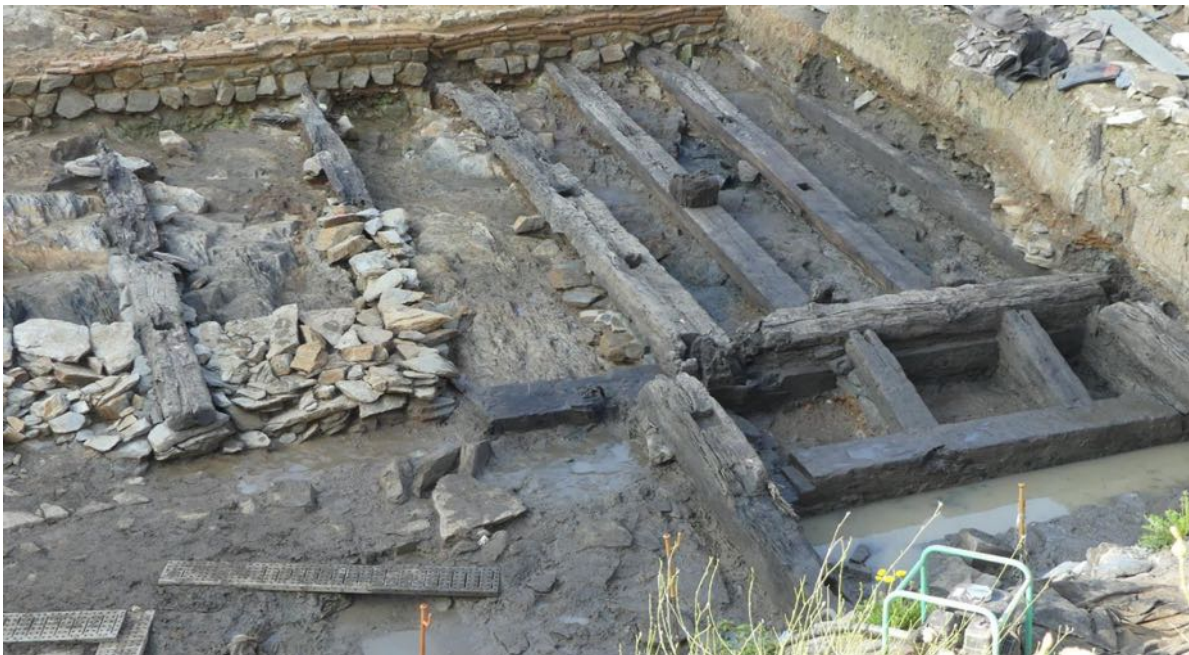
Rezé (44), aménagement portuaire (cliché E. Collado, Inrap)
