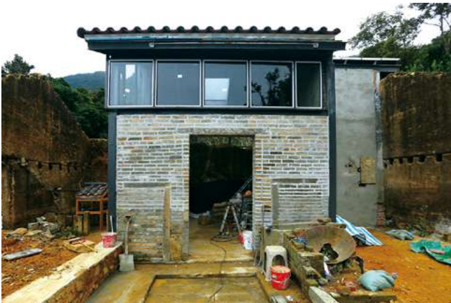
「老屋」建於1800年以前，是村內歷史最悠久的建築，村長曾玉安亦曾在此居住，現由中大建築團隊進行實驗性建築修復。門前為天井，透過天井可讓老屋中的「氣」流動，以應對濕熱天氣
