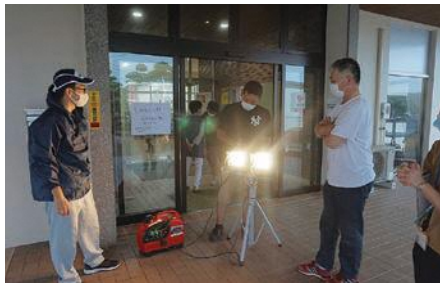
▶ 停電にそなえて発電機と電灯を設置しました (西海公民館)
