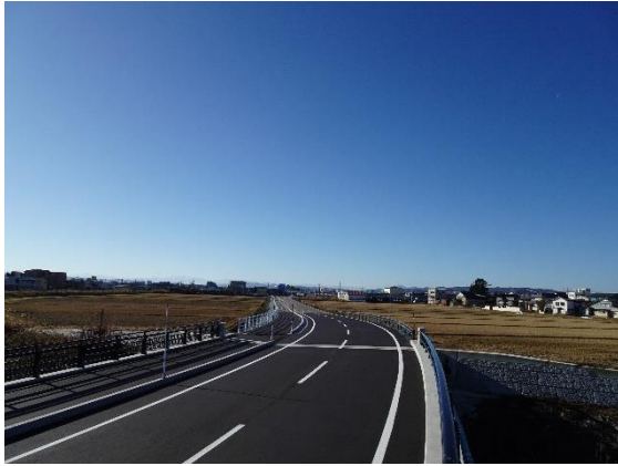
📷①：県道長岡和島線方向を望む (令和6年1月5日撮影)
