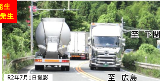
【写真③】縦断線形不良箇所
