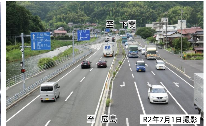
【写真②】戸田拡幅整備済区間
