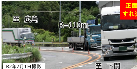
【写真②】平面・縦断線形不良箇所
