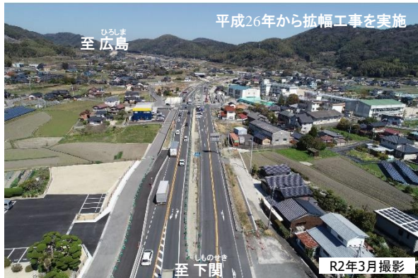
▲事業区間終点付近の状況 (写真①)
