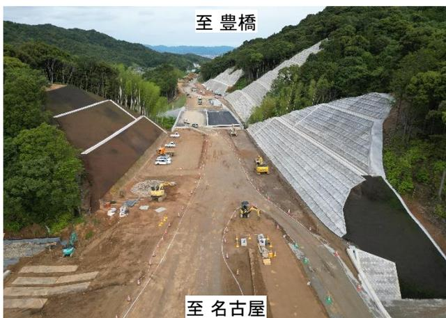
法面対策工事が完了し、改良工事を進めています
