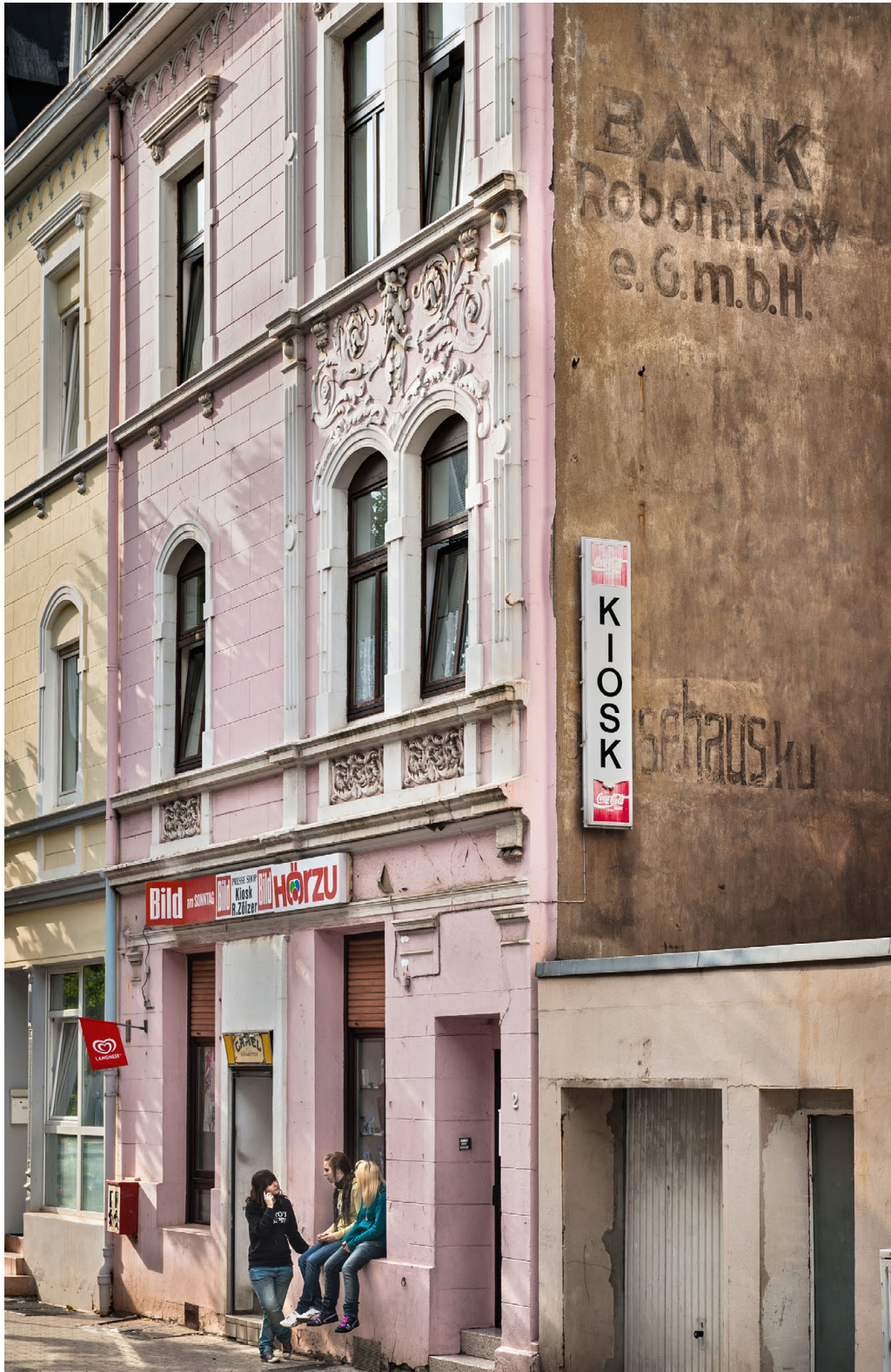
Verblichene Fassaden-Inschrift der einstigen polnischen Arbeiterbank Bank Robotników in Bochum, Im Kortländer 2, 2009
